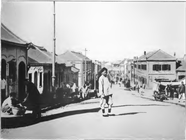
Straßenverkehr in Taipai der Chinesenstadt von Tsingtau (Kiautschou).
